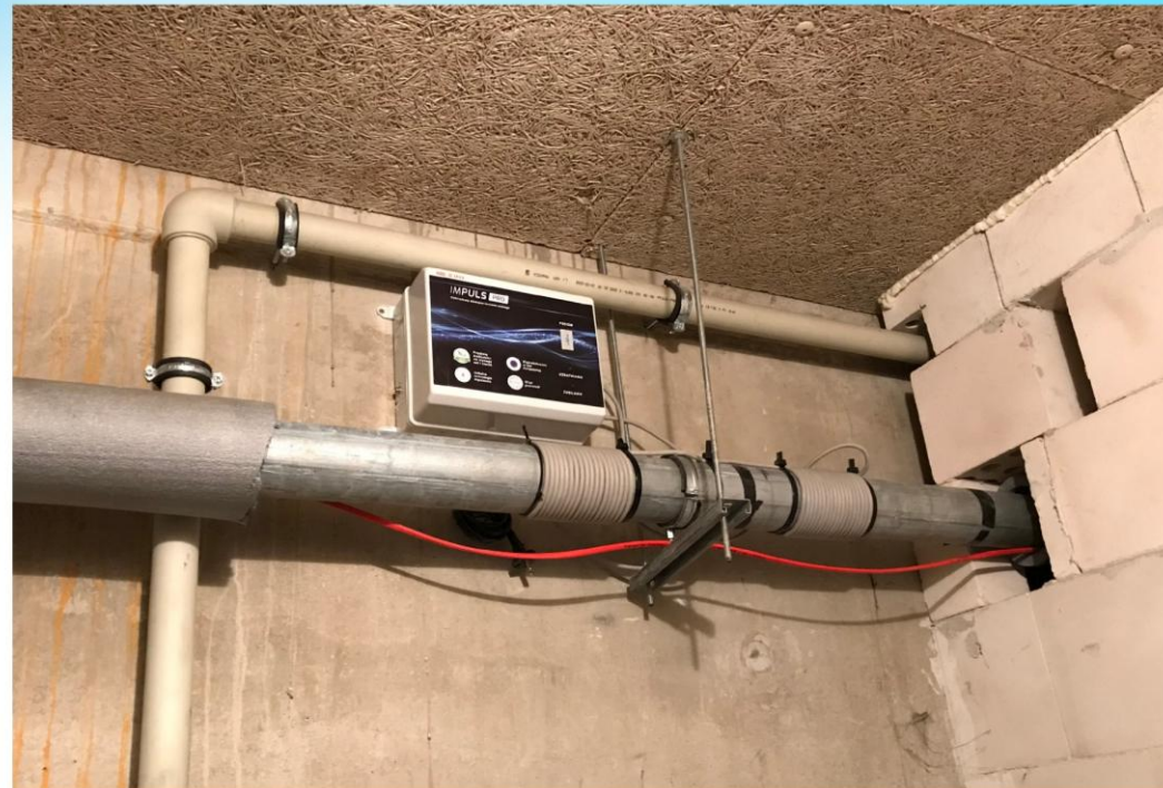
Montaż generatora Impuls PRO 80 x 2 szt
