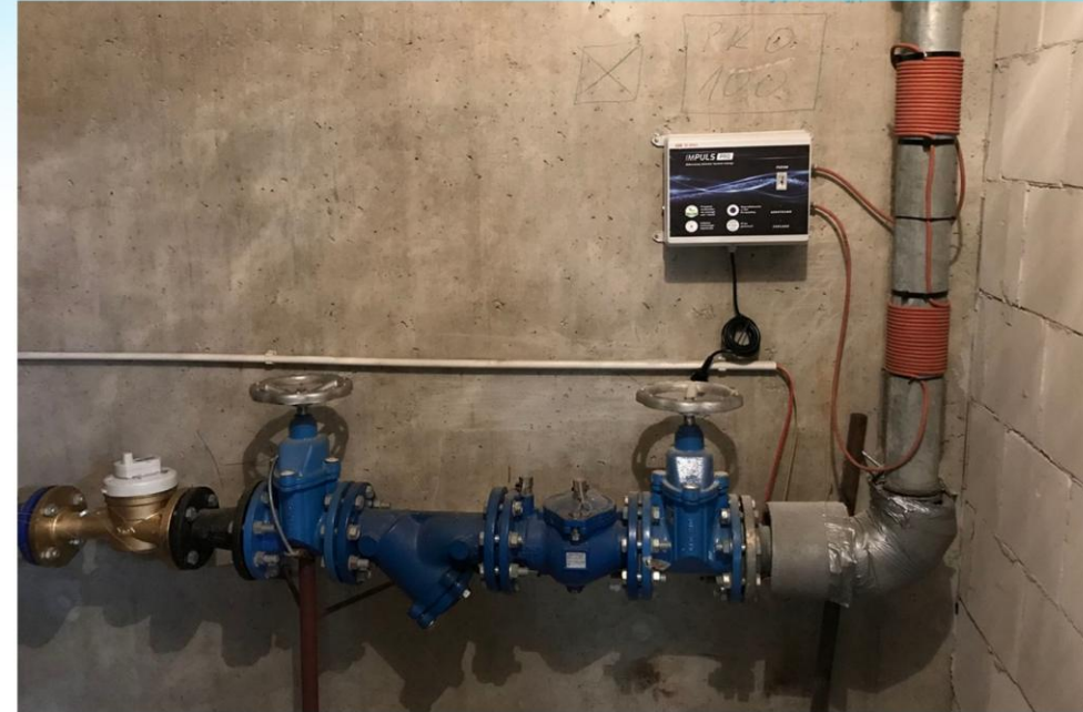
Montaż generatora Impuls PRO 80 Impuls PRO 100
