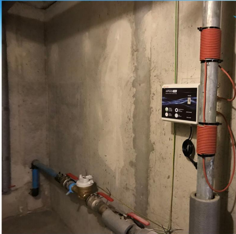
Instalacja generatora Impuls PRO 100 2 budynki wielorodzinne montaż na stali i PE
