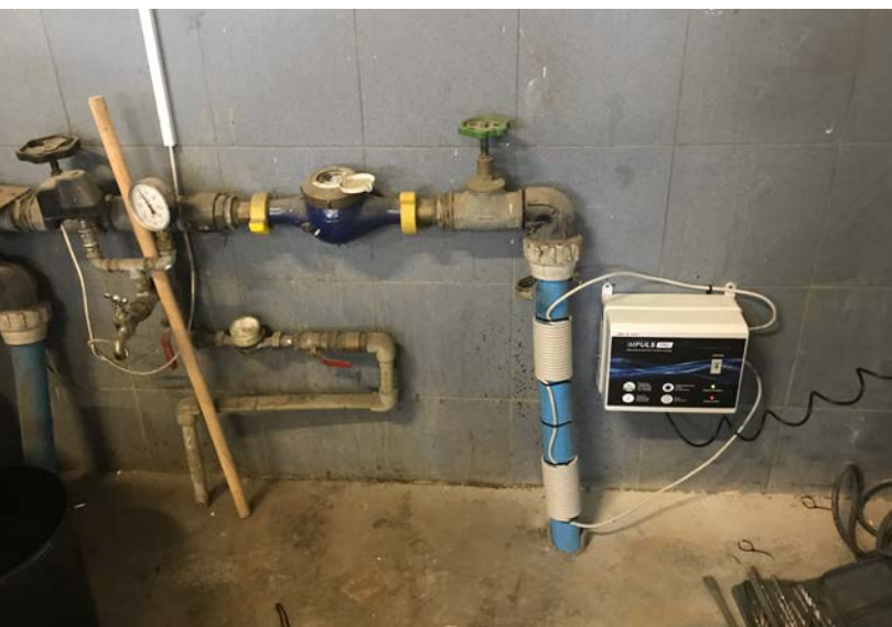
zabezpieczenie instalacji wody zasilającej zakład
