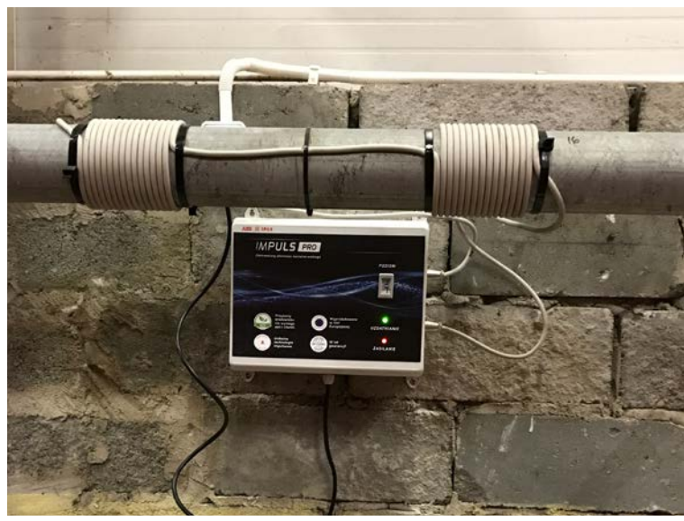
zabezpieczenie instalacji wody zasilającej zakład
