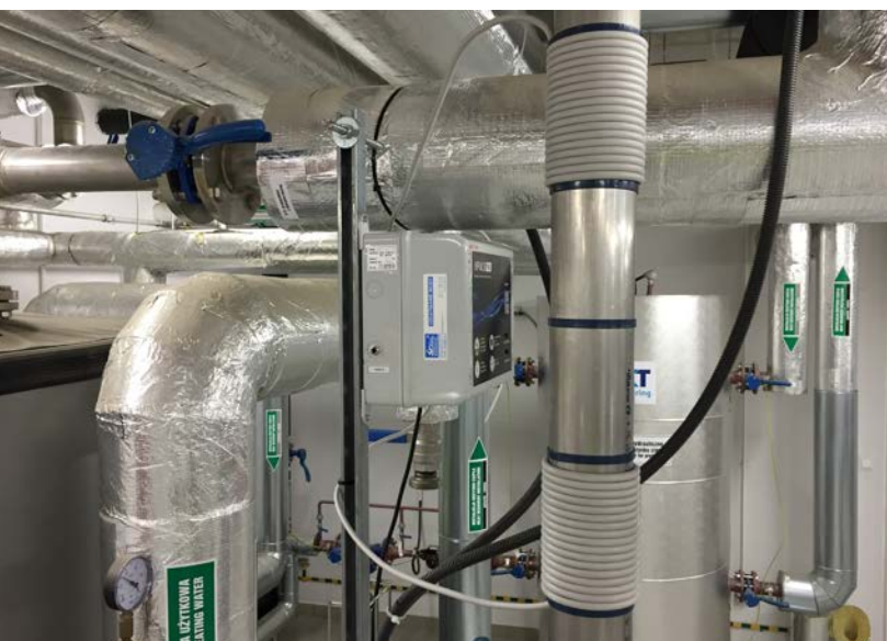
zabezpieczenie instalacji wody zasilającej zakład
