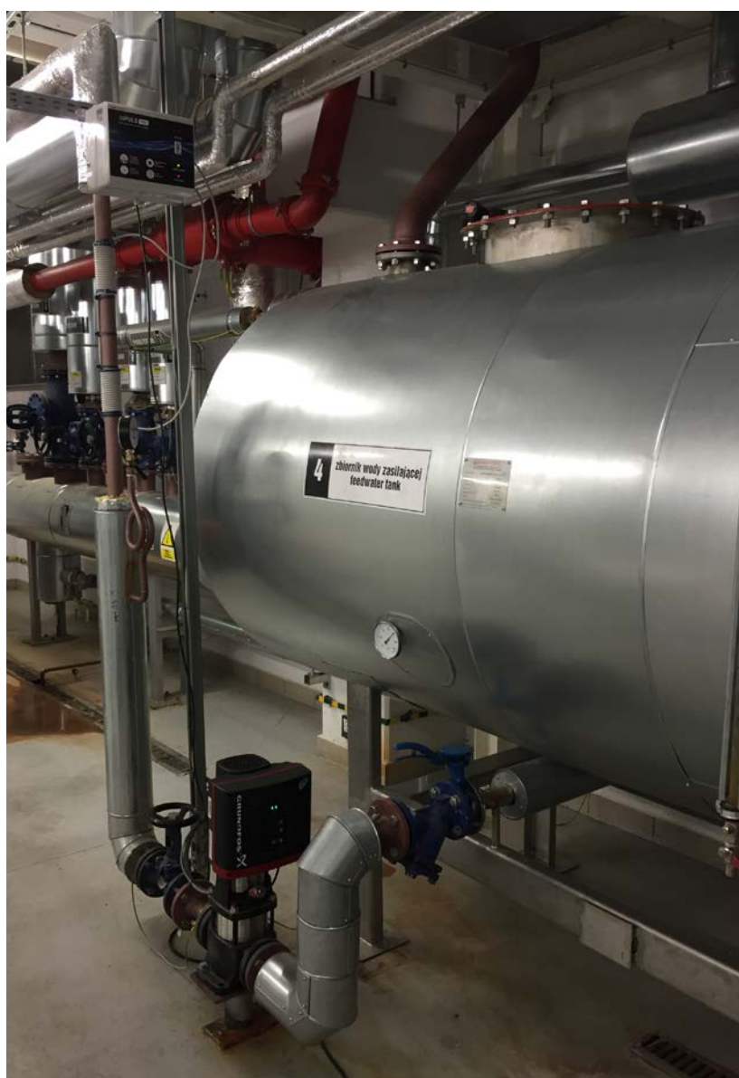
zabezpieczenie instalacji wody zasilającej kocioł
